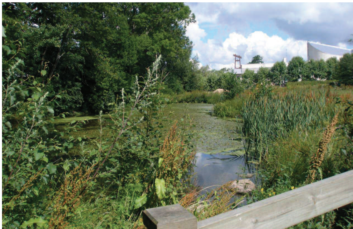
Vid Höljan i Motala stad finns en anläggning för lokalt omhändertagande av dagvatten. Dammarna utgör en fin levnadsmiljö för växter och djur samtidigt som dagvattnet renas i dammarna innan det rinner ut i Motala ström. Dammarna fungerar också som utjämningsmagasin vid kraftiga regn.
