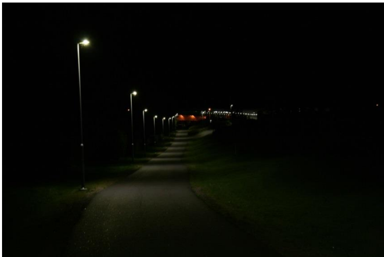
Figur 13: LED-belysning på gång- och cykelväg längs med riksväg 50.
